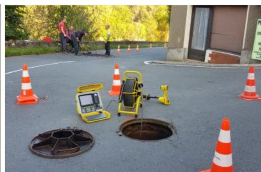
Travaux d'investigation sur les réseaux d'assainissement collectifs avec la caméra.
